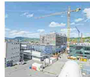
2013: Baubeginn neues Produktionsgebäude in Zofingen (Bild zeigt die Baustelle 2015).
