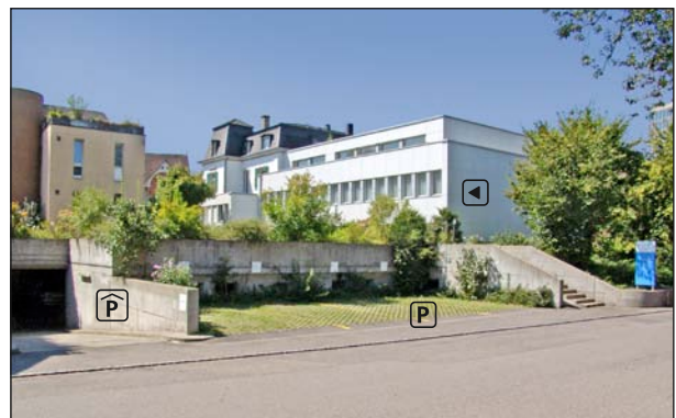
Blick von Konradstrasse Parkplätze aussen und in der unterirdischen Einstellhalle
