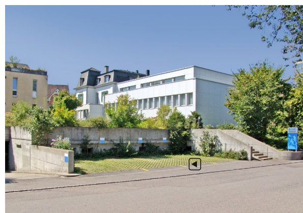
Blick von Konradstrasse, Vier Parkplätze aussen
