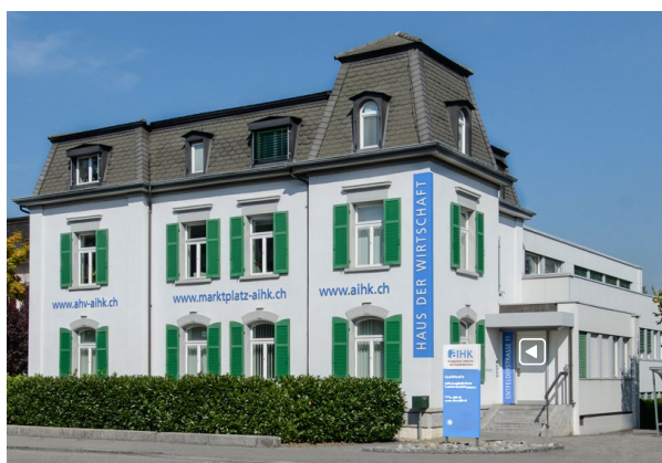
Blick von Entfelderstrasse, Haupteingang
