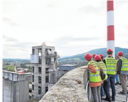
Vom Anstich der Jura-Cement-Fabrik AG in Wädenswil sieht man bis zum Steinbruch, wo das Grundmaterial für den Zement herkommt. Ramona Keller (unten links) ist Leiterin Industriekultur und führt durch den Betrieb.
