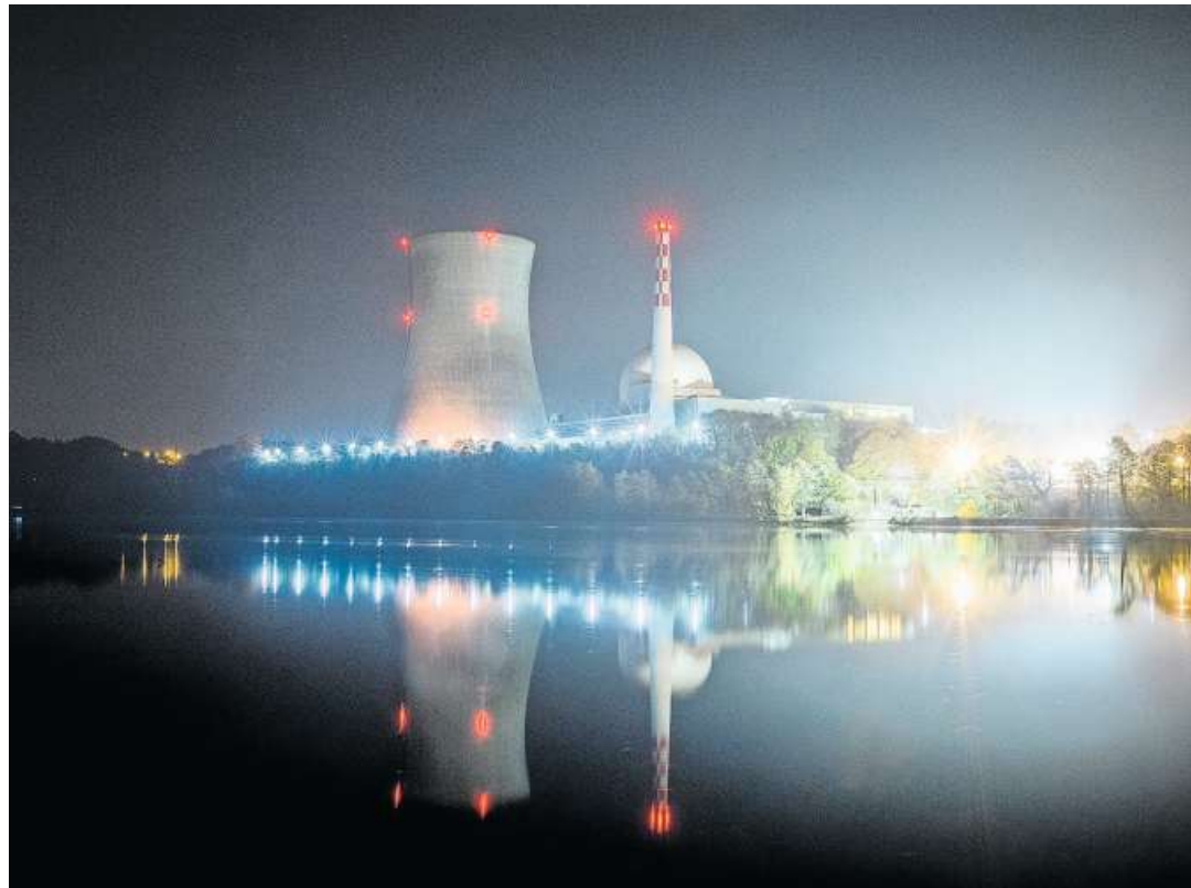
Das modernste und leistungsstärkste Atomkraftwerk der Schweiz steht in Leibstadt – nun verlangt die FDP Aargau, dass das Neubauverbot für AKW aufgehoben wird.
