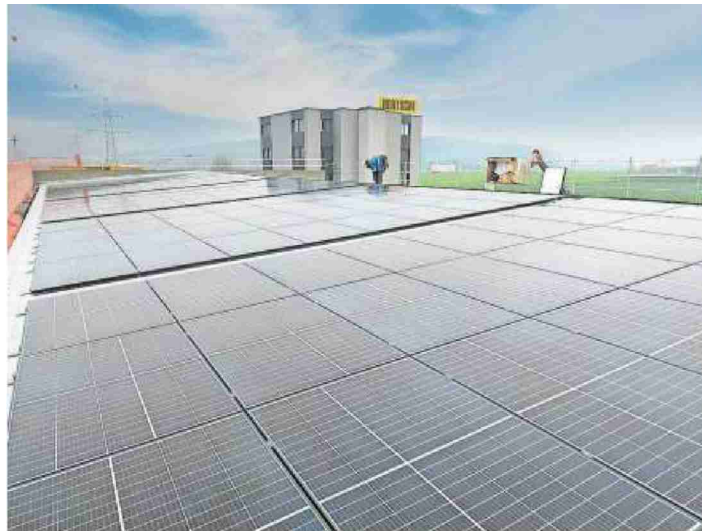
Bertschi hat drei neue Photovoltaik-Anlagen errichtet.
