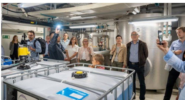
Einblick in die Technik im Bad Schinznach.
