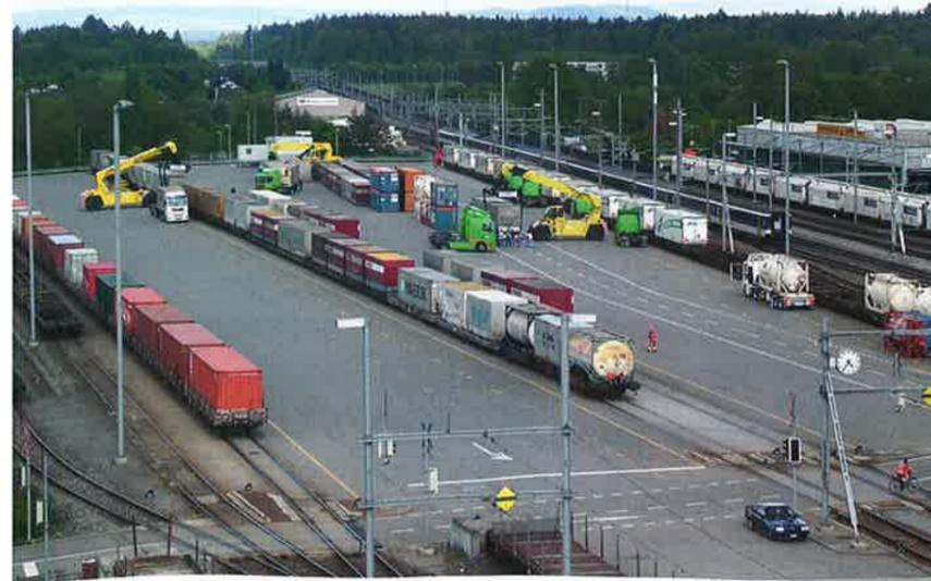
Das Terminal der Hupac AG in Aarau hat eine Fläche von etwa 20.000 Quadratmetern und kann maximal fünf Zugpaare pro Tag abwickeln.
