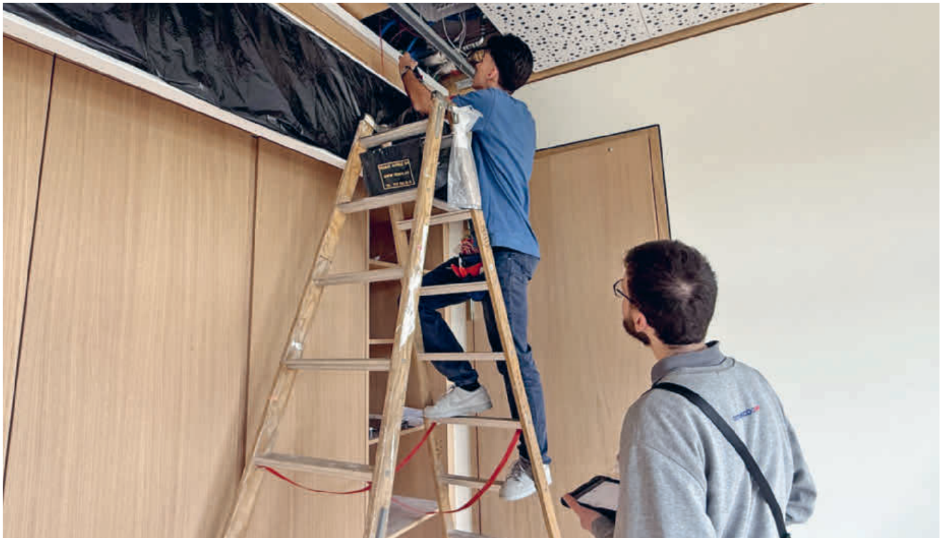
Tim Haas bei der Verkabelung auf der Leiter im neuen Haus der Wirtschaft. Sein Lernendenbetreuer überprüft die Arbeit.
